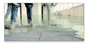
EXCELIO® est coulé directement **en pose adhérente**, sans polyane, après primairisation du support. La suppression de la manipulation des sacs et du lissage manuel diminue nettement le temps de mise en œuvre par rapport aux enduits de sols traditionnels, même appliqués à la pompe
